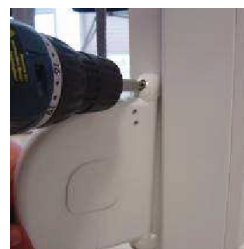
Befestigung des Gurtwicklers am Fenster mit Schrauben 4 x 20 mm
