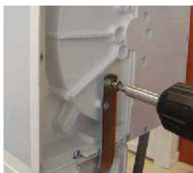
Den Halter zuerst mit Schrauben 4 x 12 mm an der Konsole befestigen. Wichtig: Die Schrauben dürfen nicht länger als 12 mm sein!
