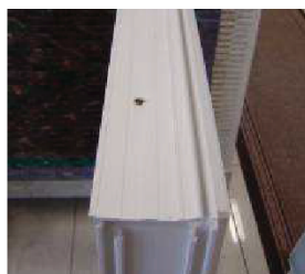
Zur Befestigung werden selbstschneidende Schrauben 3,9 x 19 mm im Abstand von ca. 30 cm verwendet
