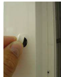
Abdecken der Bohrungen mit Abdeckkappen
