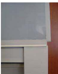
Die richtige Position der ALU-Führungsschiene liegt 7 mm vom Kastenende entfernt!
