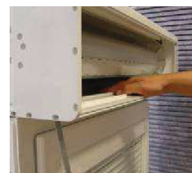
Variante B (3.) Bei breiteren Elementen muss der Kasten geöffnet und von Hand nachgeholfen werden, damit der Kasten auf dem Fensterrahmen aufsitzt
