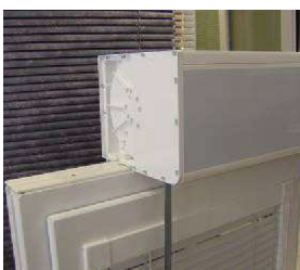
Variante A Der Kasten wird durch Aufschieben auf das Montageprofil aufgesetzt
