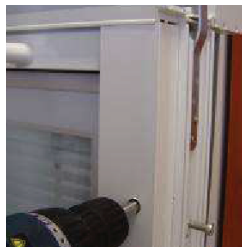
Befestigung der Führungsschiene mit Schrauben 4 x 40 mm
