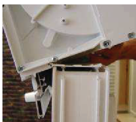
Variante B (1.) Der Kasten wird am „Zahn“ des Montageprofils eingehängt
